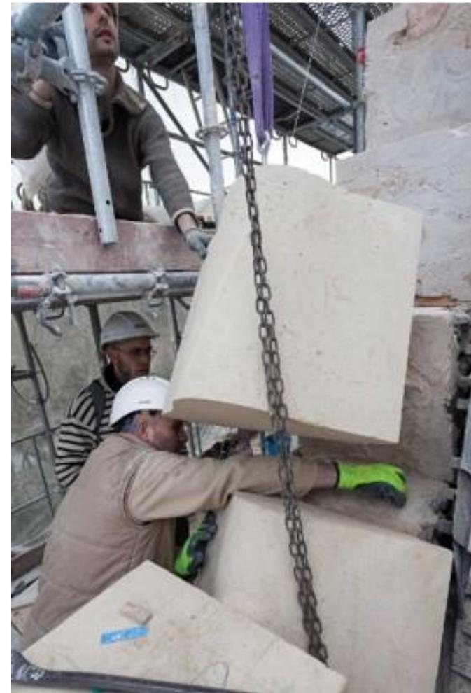
Montage des pierres des taille, une à une pour la reprise d'un arc-boutant
