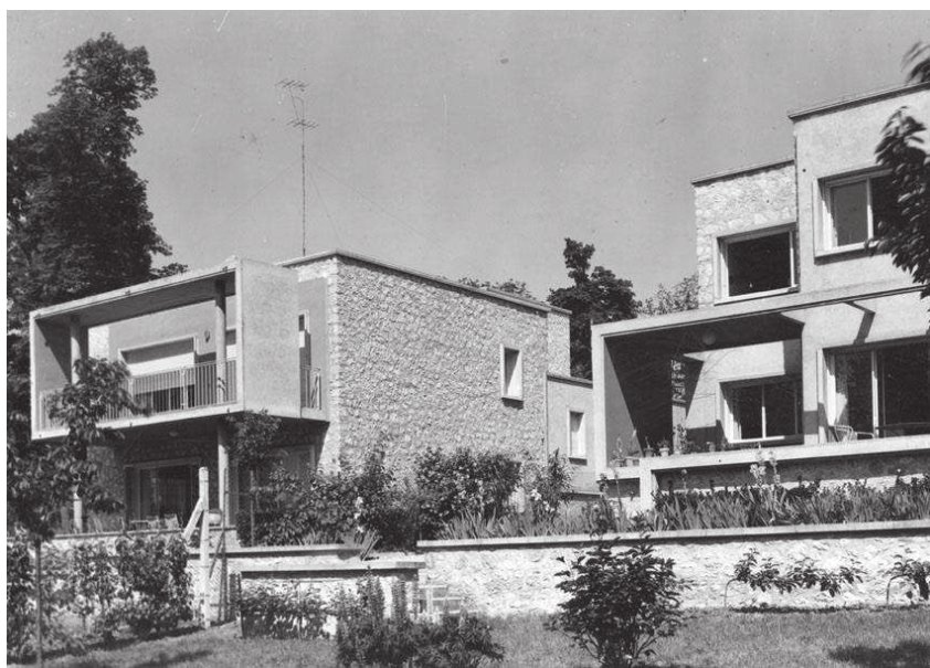
Les maisons de la rue Paul Couderc, peu après leurs constructions.
